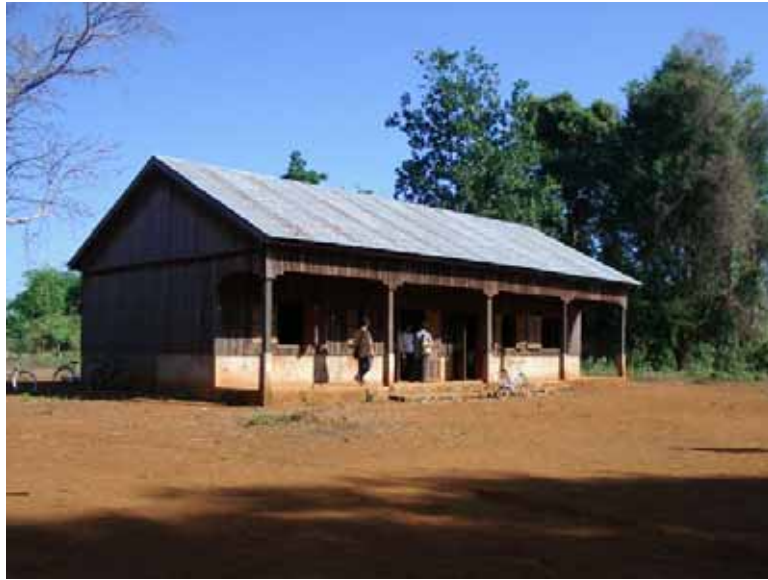
SEILA 仕様の木造校舎 Thuoy Ampil 小学校 (1棟2教室) (オーチュン郡 Cha-Ung コミューン)
